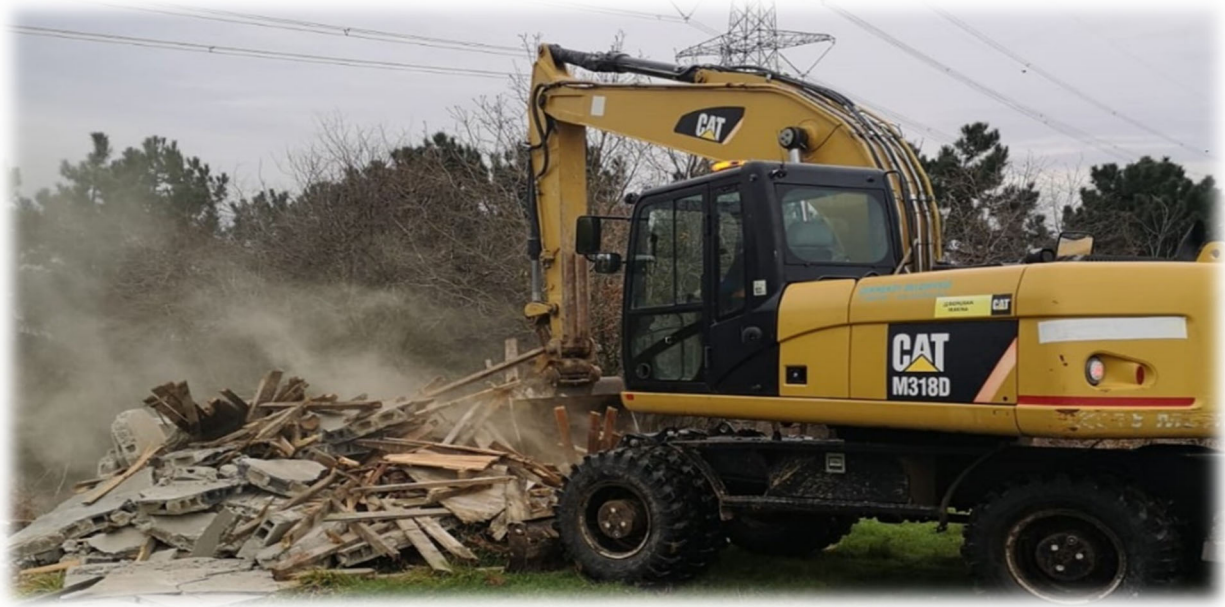
Fotoğraf 39: İnşaat Yıkım İşlemleri
