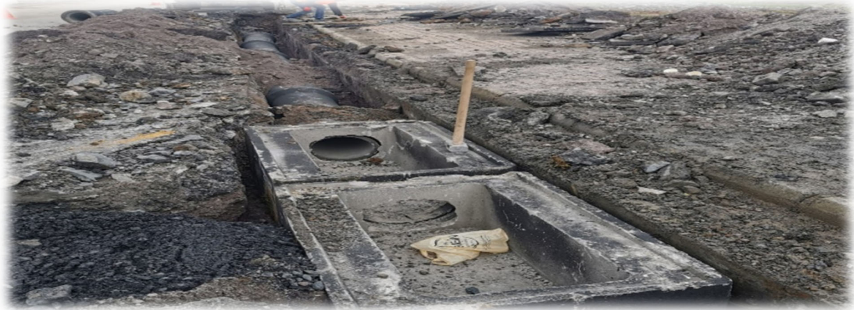
Fotoğraf 10: Yağmur Suyu Kanal İmalatı
