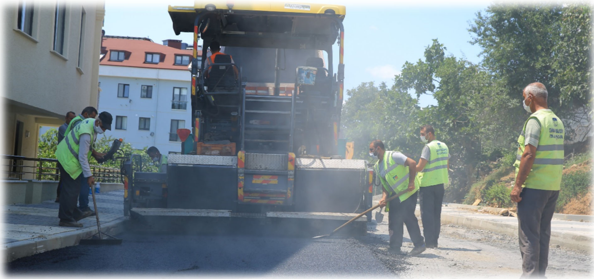
Fotoğraf 8: Yol Asfalt Yapım, Bakım ve Onarım Çalışmaları
