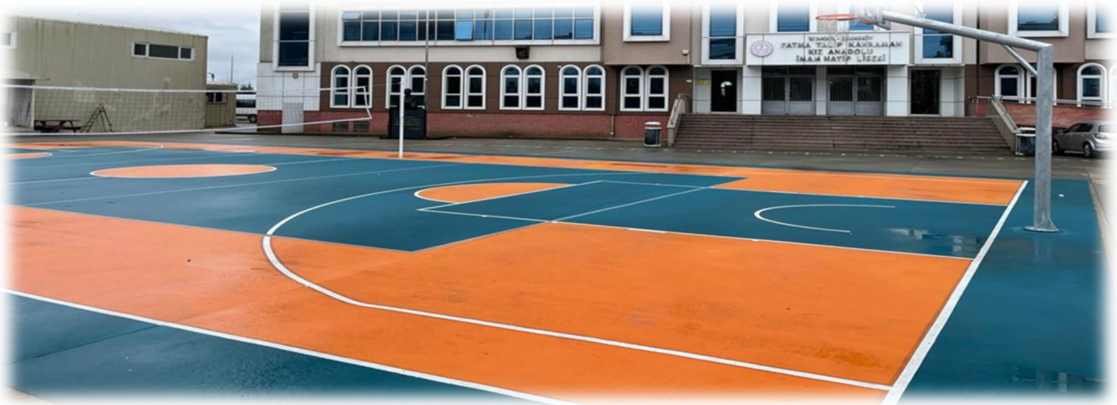
Fotoğraf 19: Mini Basketbol Sahası Yapımı
