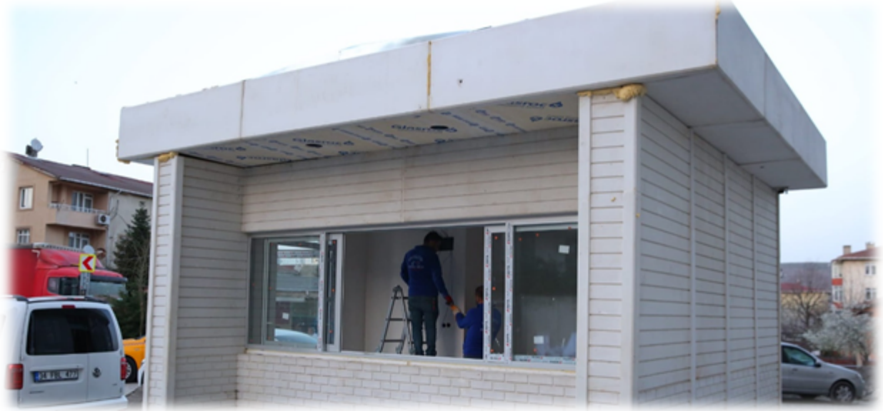
Fotoğraf 28: Taksi Durakları Yapım İşi
