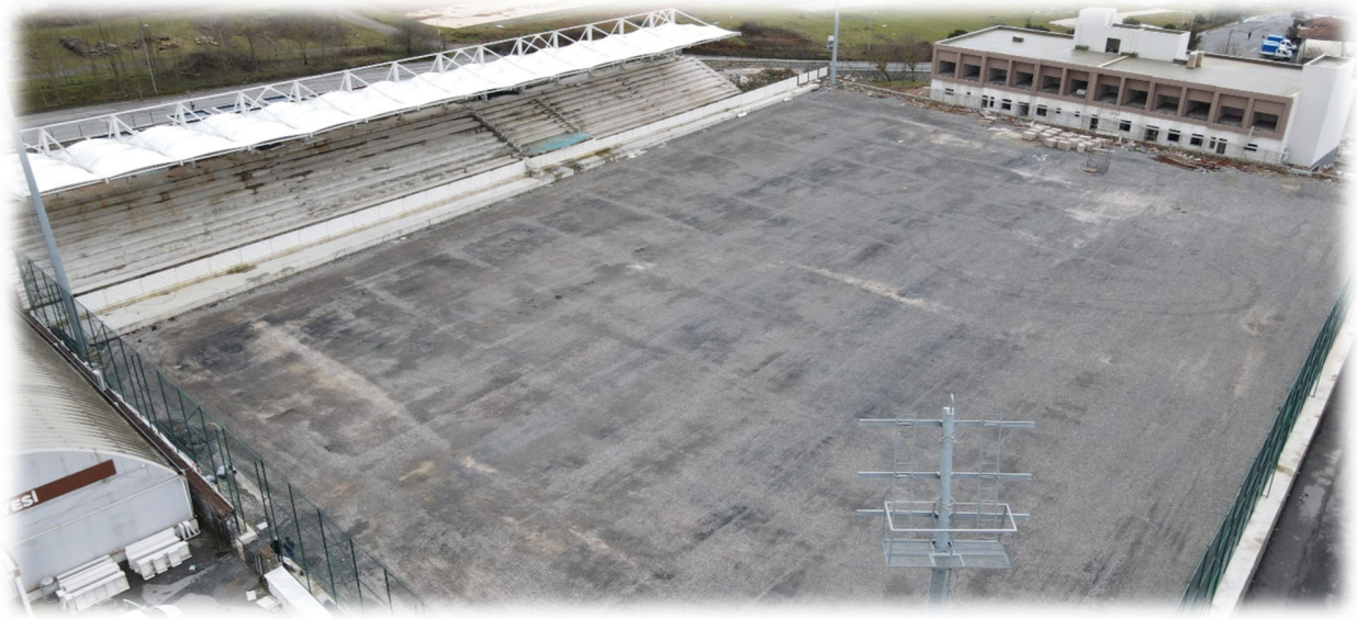
Fotoğraf 14: Ömerli Spor Kompleksi Bakım Onarımı
