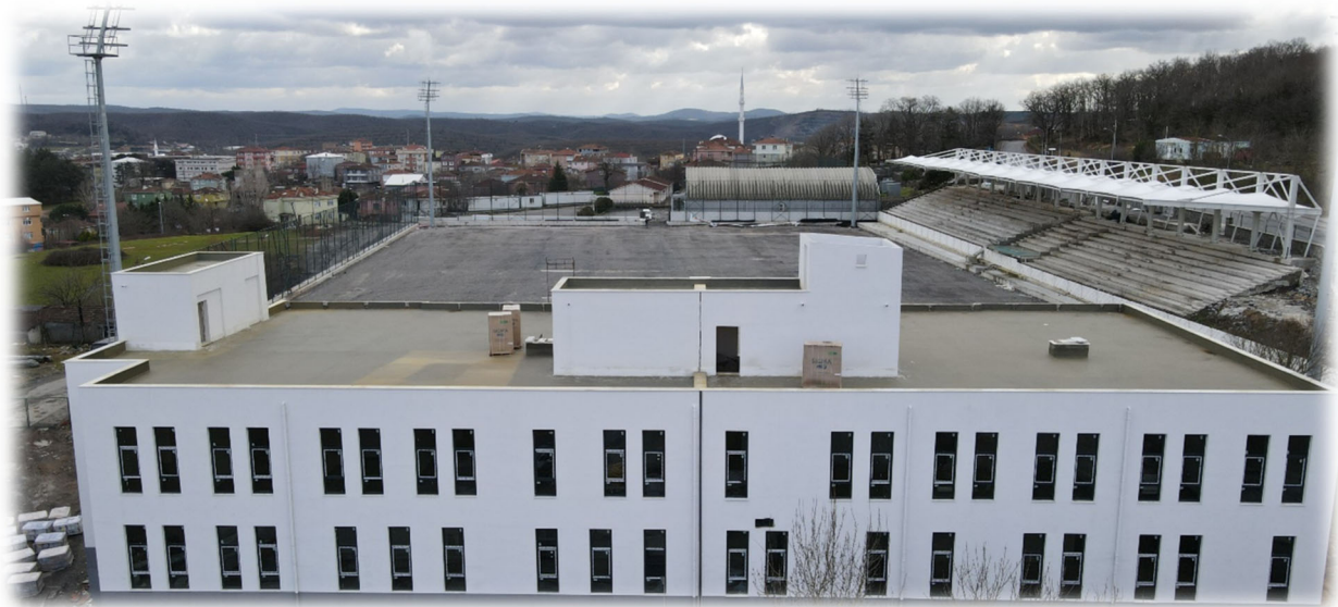
Fotoğraf 13: Ömerli Sporcu Kamp Eğitim Merkezi Yapımı
