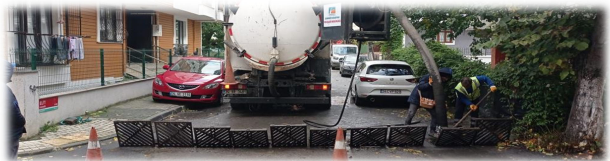
Fotoğraf 11: Yağmur Suyu Temizlik Çalışmaları
