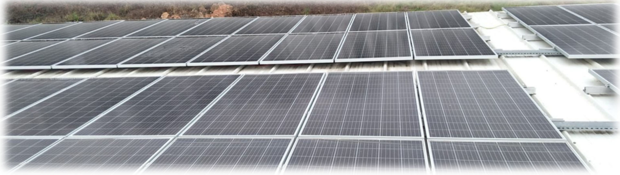
Fotoğraf 21: Güneş Enerjisi Sistemi (Panelleri) Yapım İşi
